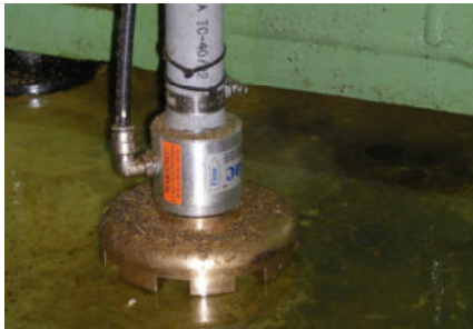
Aspirazione dell'olio che galleggia sulla superficie della vasca
