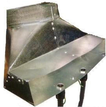
Due Gen4 Ionizing Point installati su condotta per ventilazione
